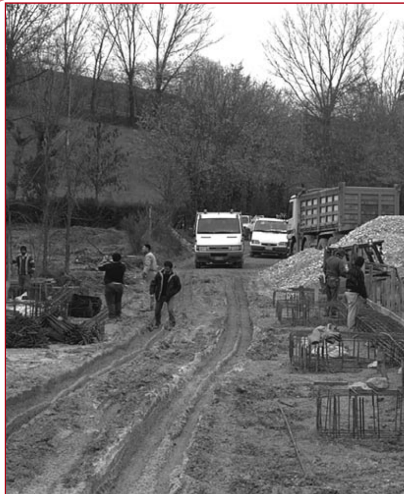
Nella foto: i lavori per la ricostruzione del ponte
